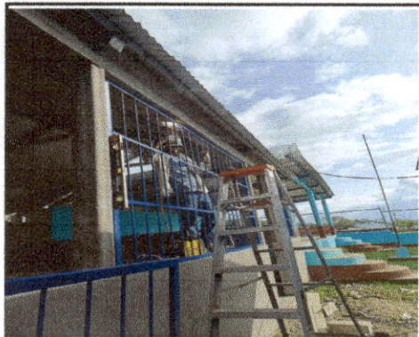
FOTO 3: Fabricación e instalación de balcones de hierro en ventanas
