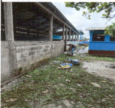
FOTO 5: Repello en muro
