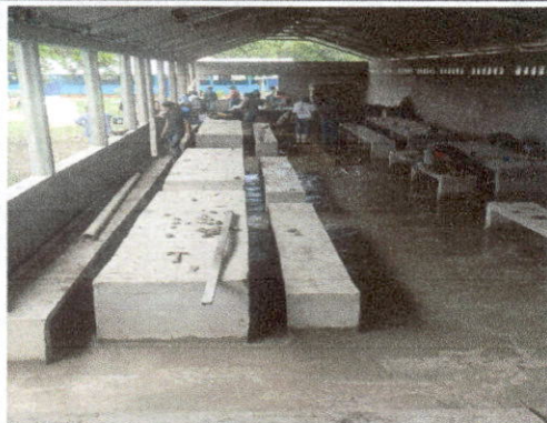
FOTO 1: Sustrucción de piso de cemento líquido
