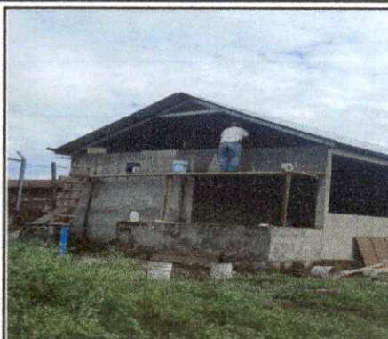
Foto 2: Construcción de culata de block.
